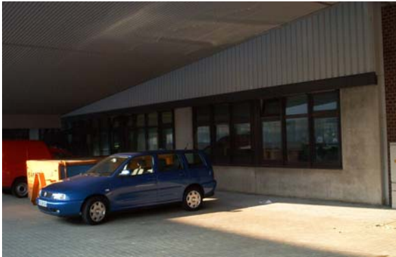
Zu demontierende Jalousien an der Halle 5
