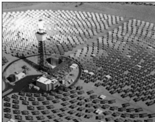
Kraftwerke nach dem Turmprinzip nutzen flache Spiegel (sogenannte Heliostaten), um Sonnenlicht auf einen Turm in der Mitte zu konzentrieren. Dort entsteht aufgrund der hohen Temperatur Wasserdampf, welcher zur Stromerzeugung genutzt wird.
