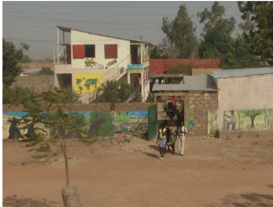
Das Solar- und Hygienezentrum in Tambacounda
