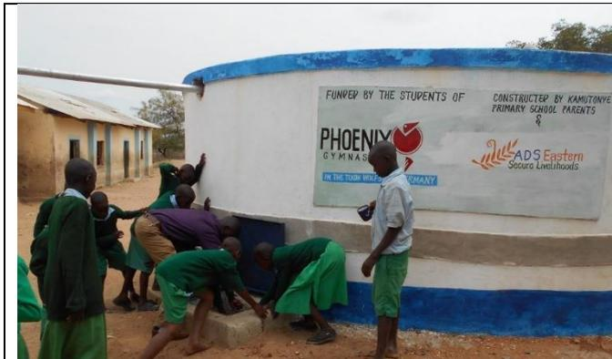
Diese Wasserentnahme-Kammer kann durch eine Eisenplatte bedeckt und mit einem Schloss gegen illegale Wasserentnahme geschützt werden.
